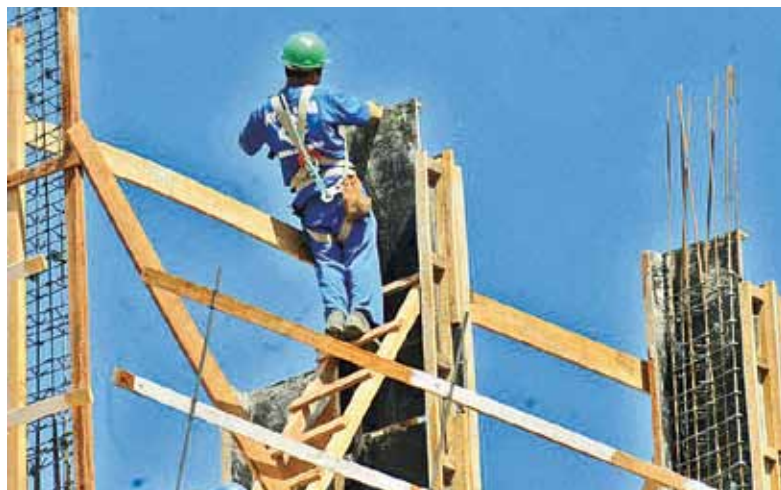
Construção civil está entre os setores com maior risco de acidentes no país
