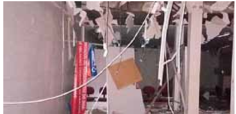
Estrutura do Bradesco em Maragogipe vai ao chão após explosão
